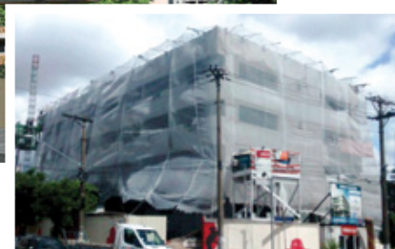
Obra em fevereiro de 2015
