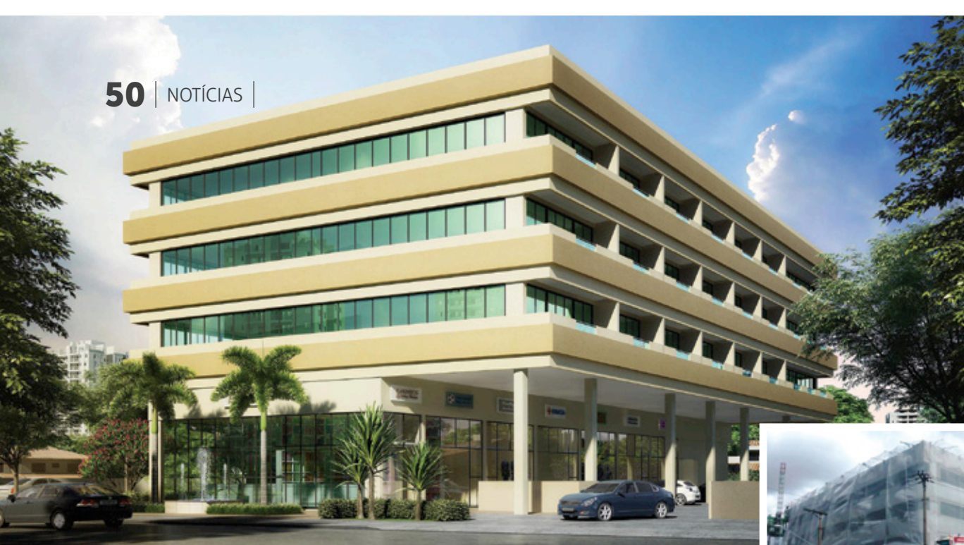
Obras do Boulevard Office estão adiantadas e a entrega do empreendimento será antecipada
