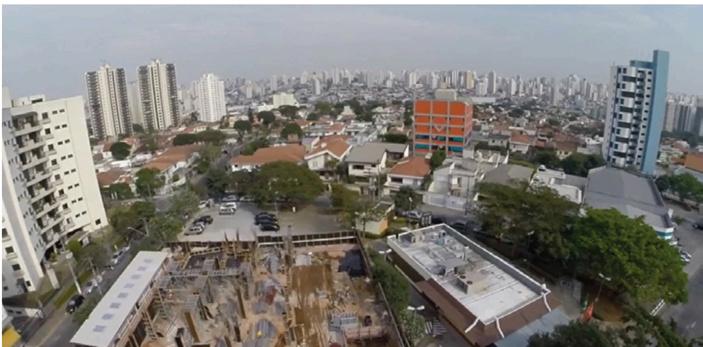
Vista panorâmica do terreno onde está sendo construído o empreendimento comercial Boulevard Office (set-2014)
